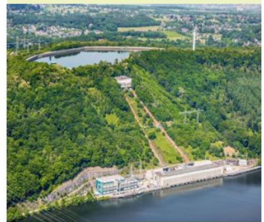
Fig. 4 : Réservoirs haut et bas d'une station de stockage d'énergie par pompage hydraulique (Herdecke, Allemagne).
